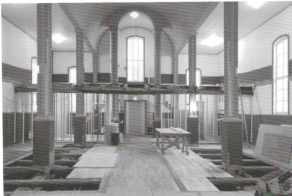
Travaux de rénovation de la chapelle.
