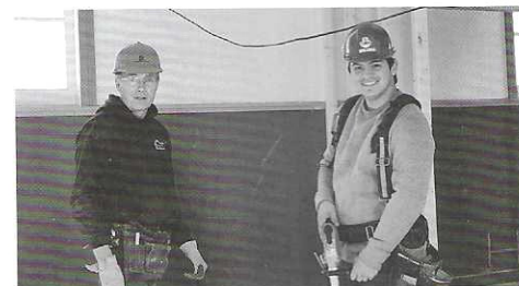
Travailleurs sur le chantier de la chapelle.
